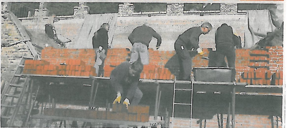
Ehrenamtliche Arbeit mit Kelle und Mörtel: Die „Freunde des Winzerberges“ trafen sich am Samstag zum Arbeitseinsatz und zogen dabei eigenhändig eine aus 1450 Ziegeln bestehende Stützwand hoch. 2015 soll die historische Anlage wieder hergestellt sein. Fotos (2): Andreas Klaer
