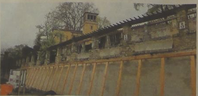
Vor Wand „B“ steht die Grundkonstruktion der Gewächshausfenster.
